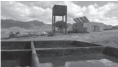
IMAGEN 4. SISTEMA DE ÓSMOSIS INVERSA FOTOVOLTAICA INSTALADO EN TANGARFA (MARRUECOS). FUENTE: ITC.
